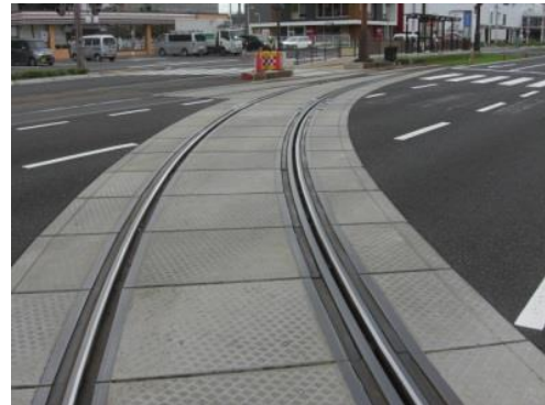
軌道改良のイメージ 【神田（交通局前）電停付近】
