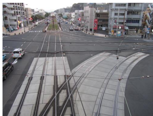
軌道改良 (郡元電停交差)
